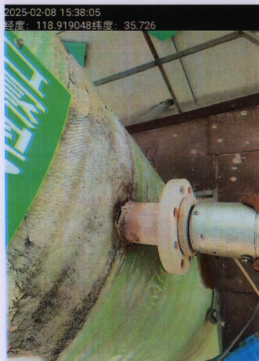
有组织现场采样照片
